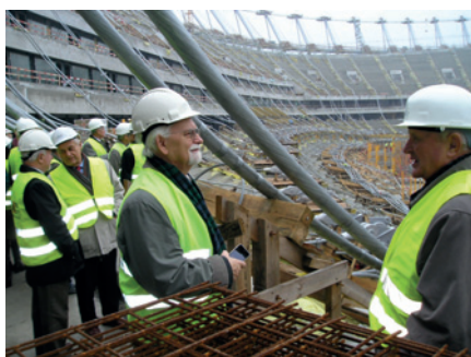
Dotarliśmy na koronę stadionu. Stąd najlepiej widać ogrom przedsięwzięcia.
