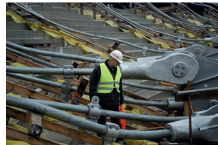
Grube liny (10 cm średnicy) leżą jeszcze na widowni. Po naciągnięciu będą podtrzymywały 5-hektarowy dach stadionu.
