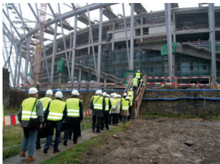
Stalowe słupy podtrzymujące pierścień, do którego mocowane są zastrzały i liny stalowe dachu zwiększyły wysokość stadionu o ponad 50 metrów.
