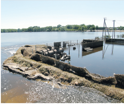
Zalana pompownia w Dobrzykowie (foto Stanisław Maciejewski)
