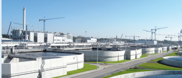
Oczyszczalnia ścieków „Czajka”
