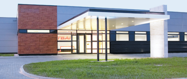
Fabryka siedzeń samochodowych TBAI
