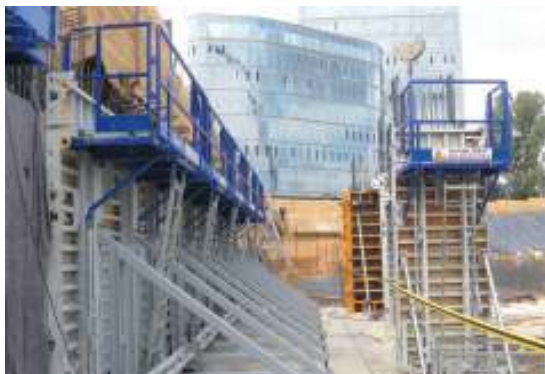
Bariery stosowane do ochrony zewnętrznej krawędzi stropu.
