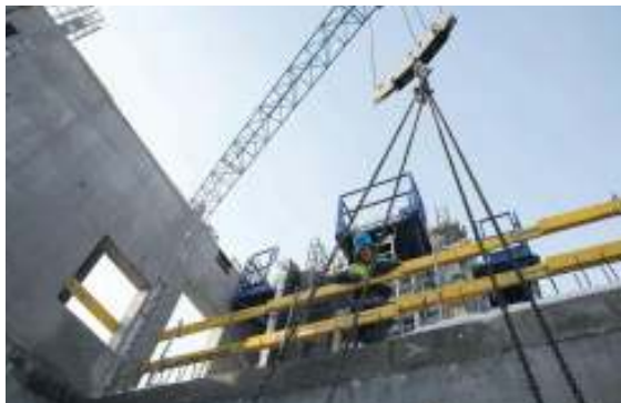
Barierki stosowane do ochrony zewnętrznej krawędzi stropu.
