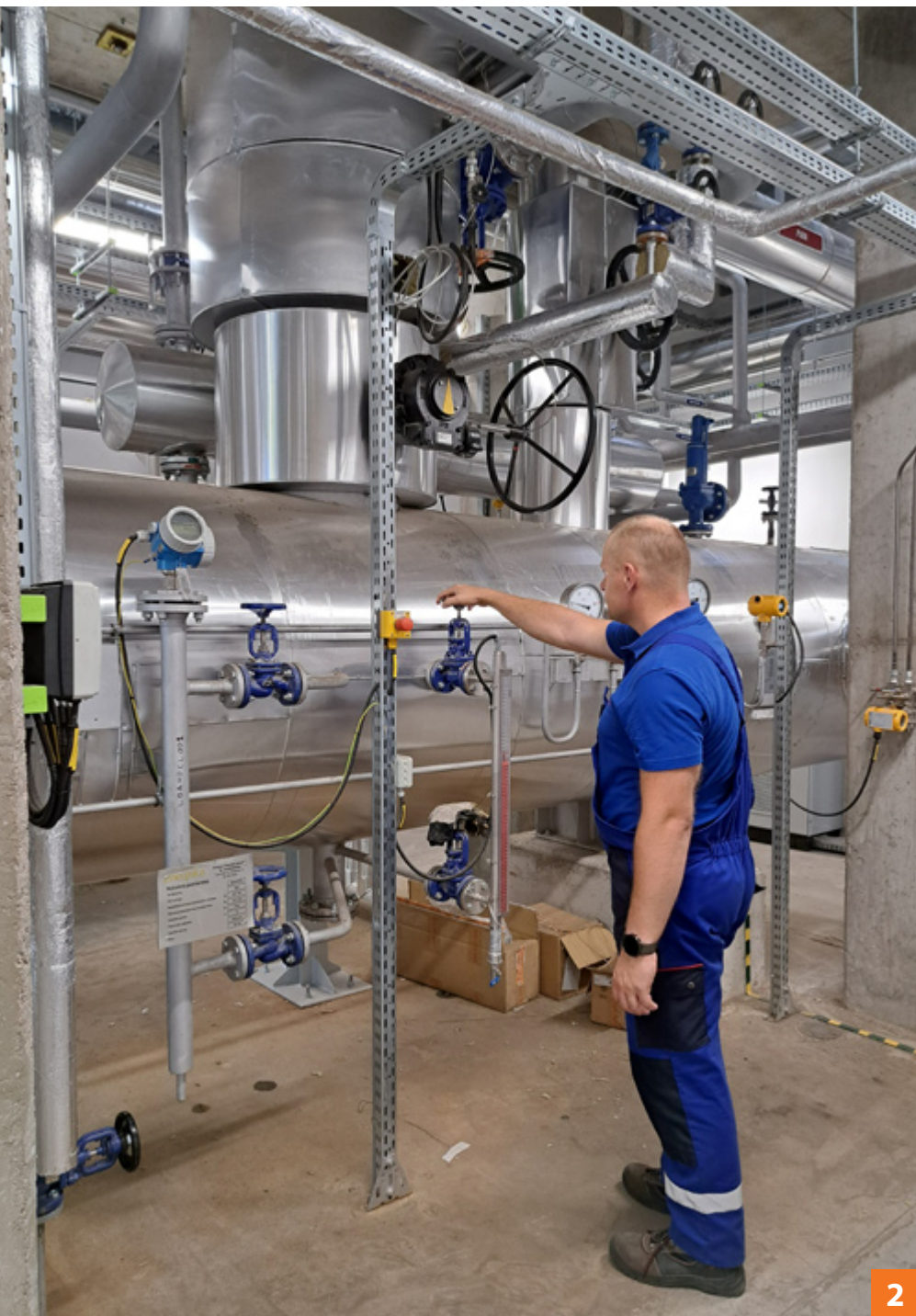
FOT. ELEKTROCIĘPOWNIA W CIECHANOWIE (DAWNEJ PEC), MATERIAŁY PRASOWE
