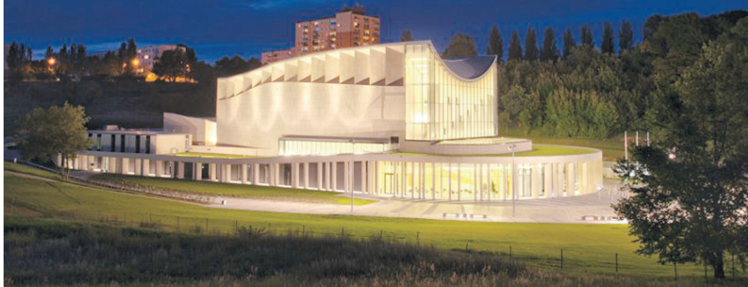
u góry: Centrum Edukacji Artystycznej – Filharmonia Gorzowska w Gorzowie Wlkp. Inwestor: miasto Gorzów Wlkp., gen. wyk.: konsorcjum spółek, kier. budowy: mgr inż. Sławomir Luzziński, inspektorzy nadzoru: Lech Mackiewicz, Krzysztof Pocałujko, Józef Lachowski, Artur Widziński, główni projektanci: mgr inż. arch. Daniel Frać, mgr inż. Roman Nalewajko, mgr inż. Arkadiusz Klucznik.
