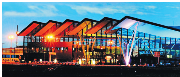
u dołu: Drugi terminal Portu Lotniczego w Gdańsku. Inwestor: Port Lotniczy Sp. z oo w Gdańsku, gen. wyk.: Budimex w Warszawie, korporacja budowlana DORACO sp. z oo Gdańsk, kier. budowy: Janusz Buczeń, inspektor nadzoru: mgr inż. Henryk Stachurski, gł. projektanci: mgr inż. arch. Mariusz Rutz, mgr inż. arch. Zbigniew Pszczelny, mgr inż. Marcin Wesoły, mgr inż. Mieczysław Matejko.
