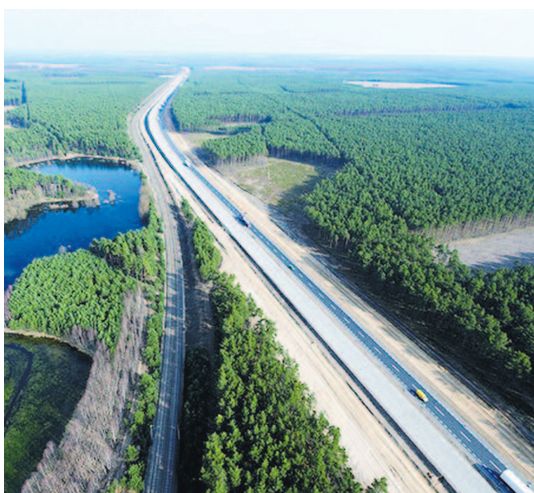
u dołu: Odcinek II autostrady A-2 Nowy Tomyśl – Świecko. Inwestor: Autostrada Wielkopolska II SA, główny wykonawca: Strabag Sp. z oo, Pruszków, kierownicy budów: Andrzej Łabędzki, Mateusz Burdziński, Andrzej Habrat, Mirosław Zator, Tomasz Matuszewski, Marcin Olczyk, Marcin Szczepański, insp. nadzoru: Ryszard Dubno, główni projektanci: jednostka projektująca ORTOTRANS SA, Gdańsk.
