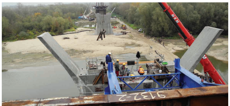
Teren budowy mostu w Solcu
