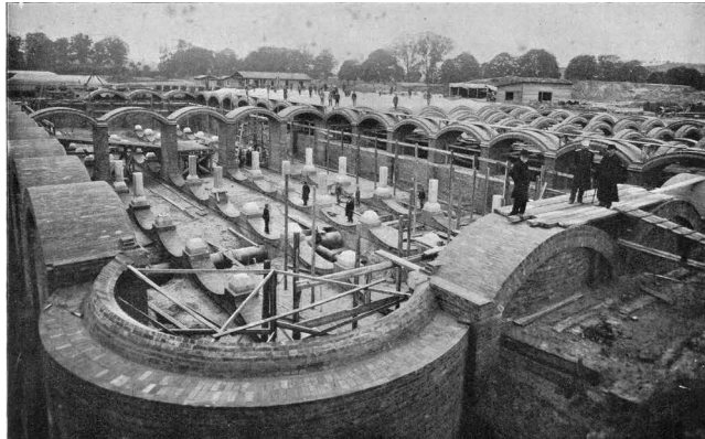
Budowa zbiornika do czystej wody - fot. archiwum MPWiK
