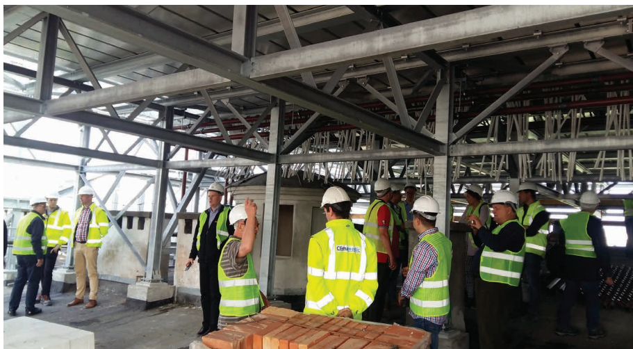
Konstrukcja nośna lotniska
