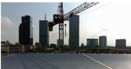
Pokrycie płyty lądowiska z aluminiowych paneli
